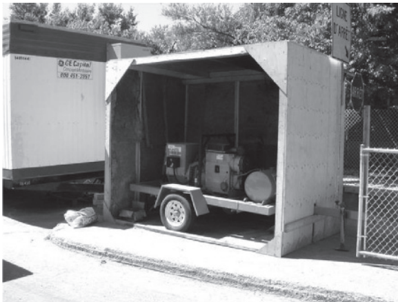
Figure 9.9-3 Écran entourant un équipement fixe
