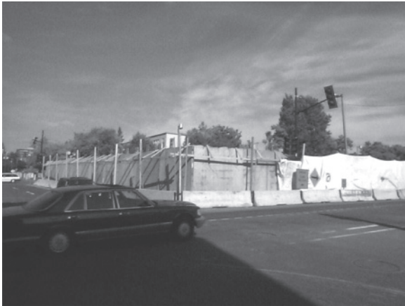
Figure 9.9-1 Écran temporaire entourant un chantier
