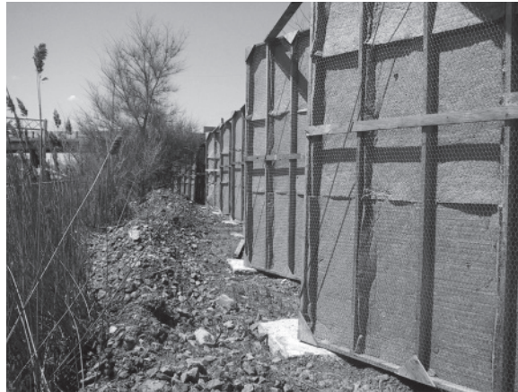
Figure 9.9-2 Écran temporaire, vue côté source de bruit
